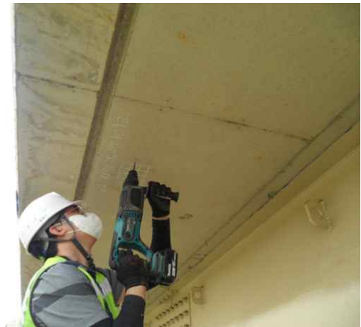
탄산화깊이 측정 현황
