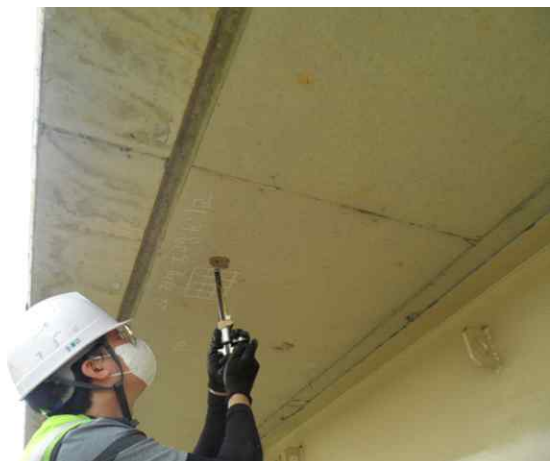
탄산화깊이 측정 현황
